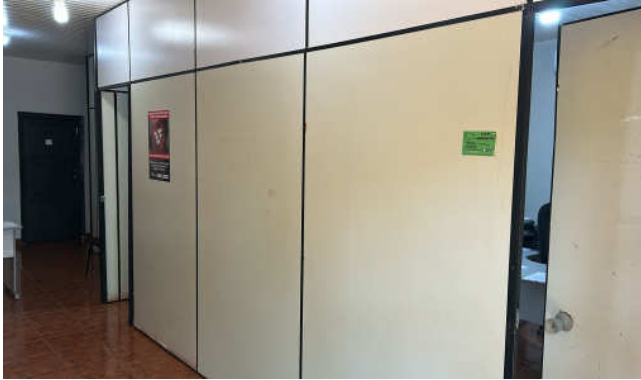
F 05 – Detalhe de divisórias em madeira que serão trocadas por paredes drywall.
