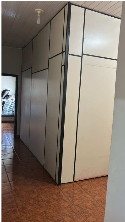
F 07 – Detalhe de divisórias em madeira que serão trocadas por paredes drywall.
