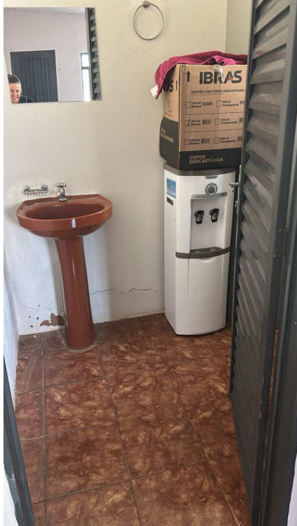
F 05 – Banheiro que será adequado para pessoas com mobilidade reduzida.
