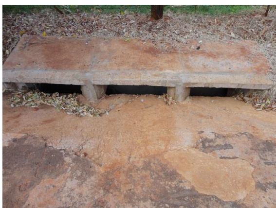
Foto 6.1 – Boca de lobo tripla no Rua Santa Catarina
