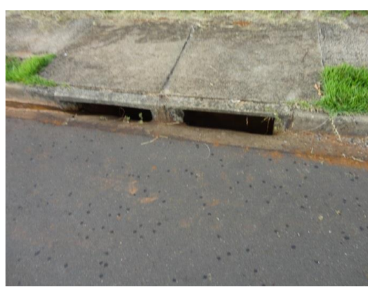
Foto 6.4- Boca de lobo dupla da Rua Mato
