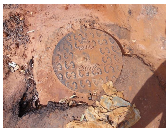
Foto 6.2- PV de águas pluviais da galeria na Rua Sergipe
