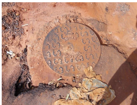
Foto 3.2 – PV de águas pluviais da galeria na Rua Sergipe
