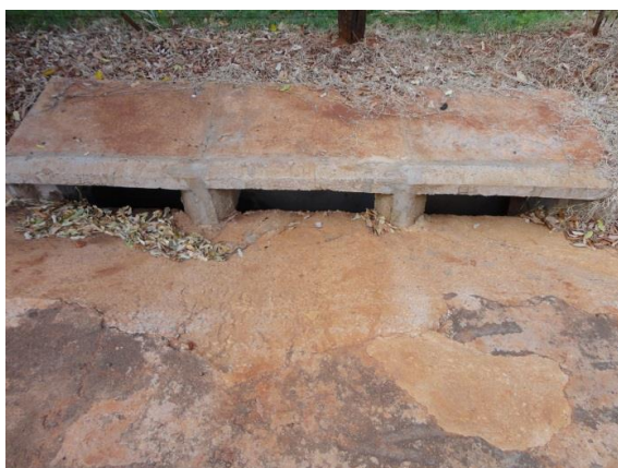
Foto 3.1 – Boca de lobo tripla no Rua Santa Catarina
