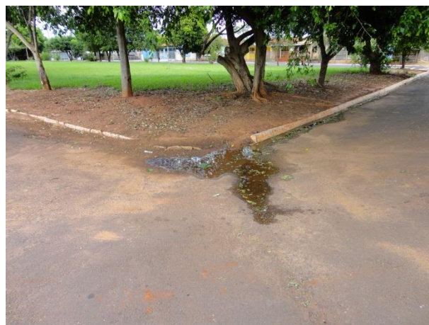
Foto 3.8 – Ponto de Alagamento entre as Ruas Guanabara e Paraná
