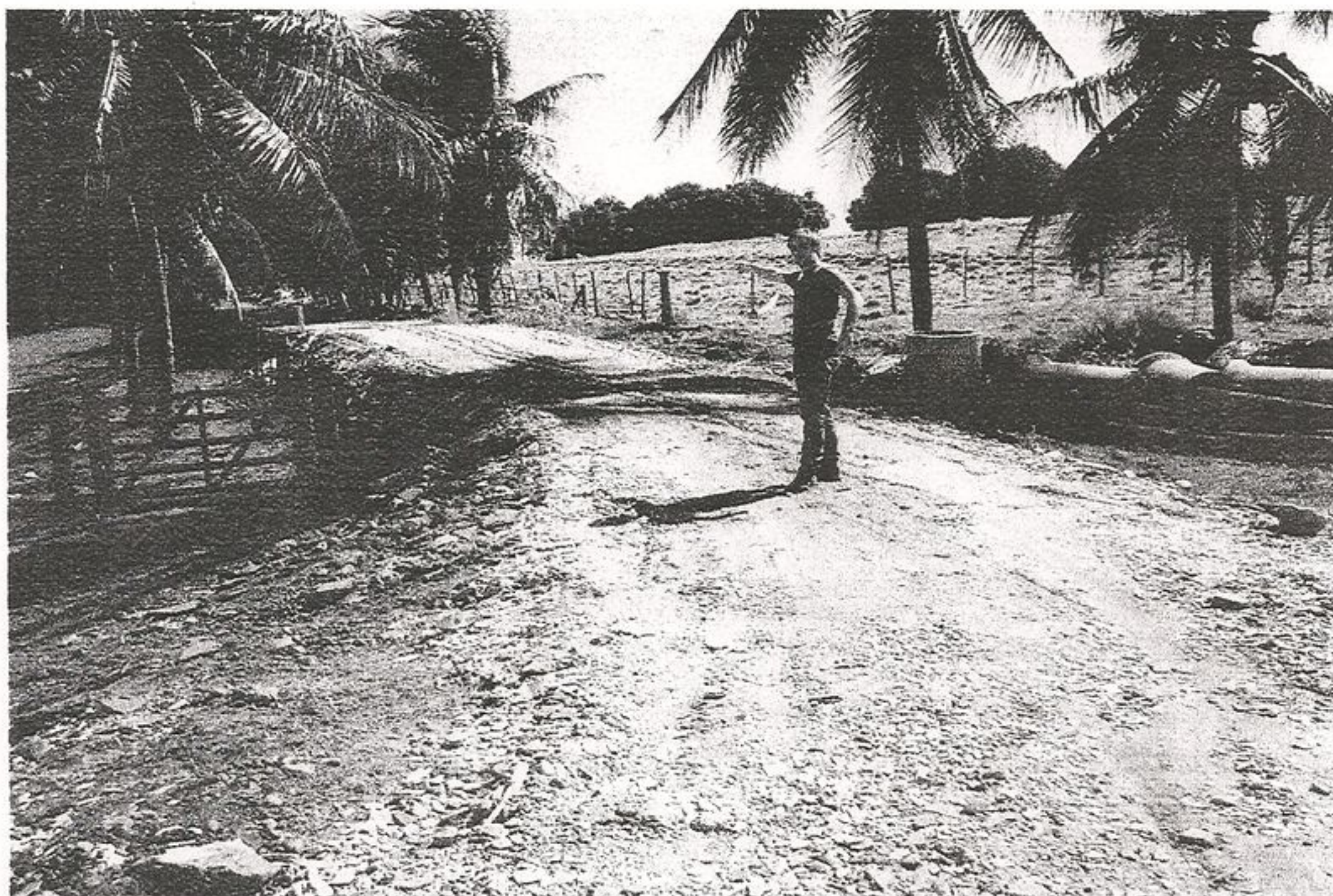
Foto 14 – Disposição de RCC em Estradas Rurais do Município
