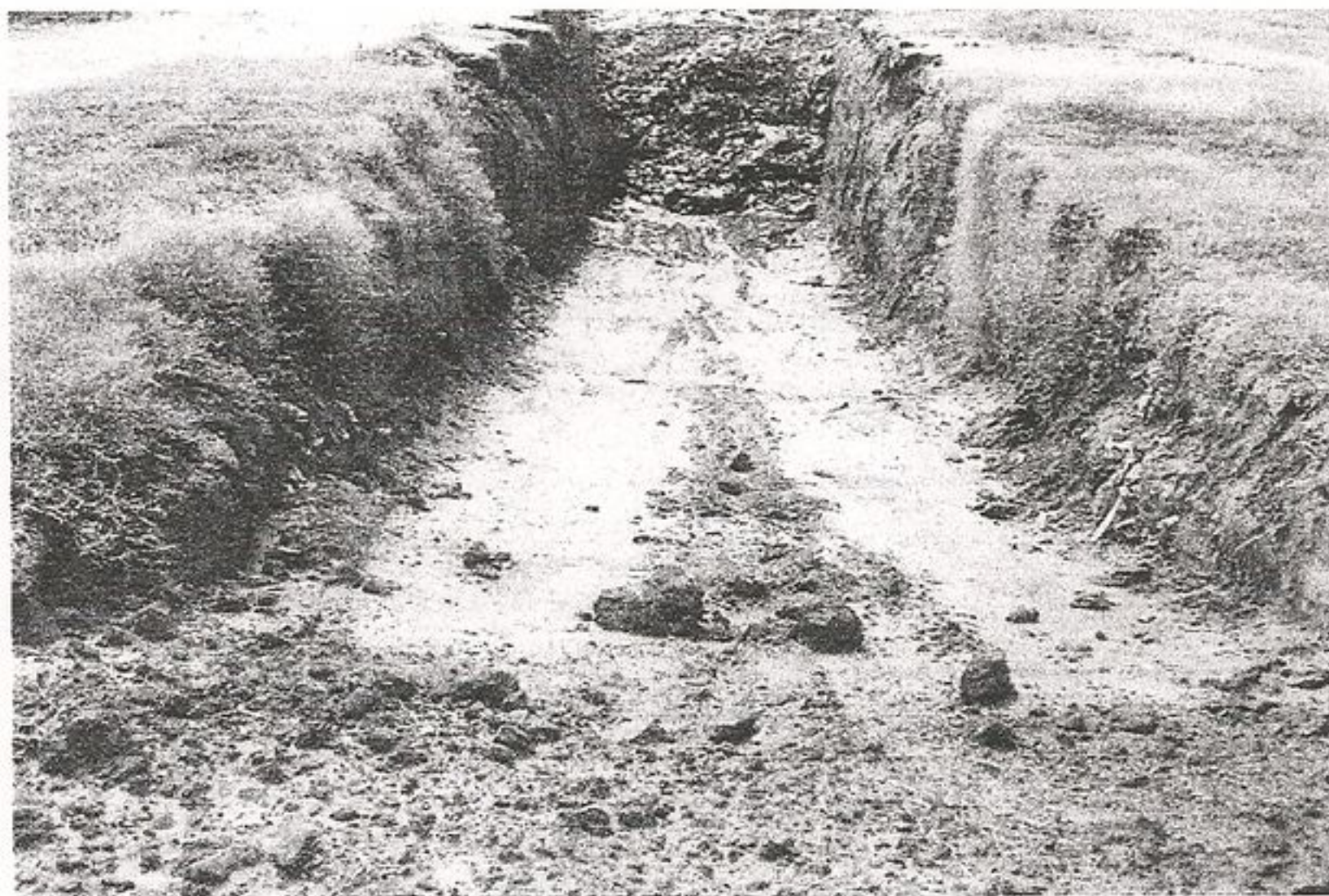
Foto 6 – Abertura da Vala
